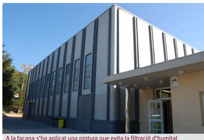
A la façana s'ha aplicat una pintura que evita la filtració d'humitat
