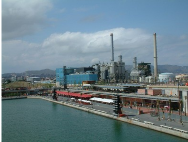
Planta incineradora de Residus Sòlids Urbans
