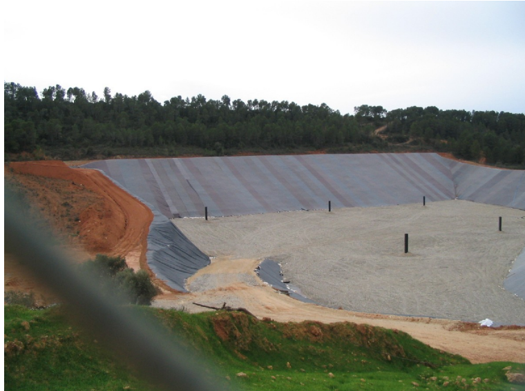
Abocador de residus sòlids urbans en procés de construcció.
