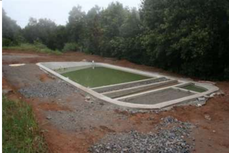
Vista aèria d'una estació depuradora d'aigües residuals
