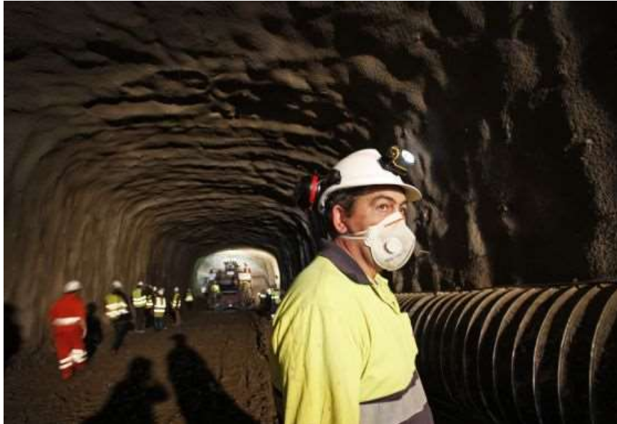
Galeria de les mines de potassa de Sallent (Barcelona).
