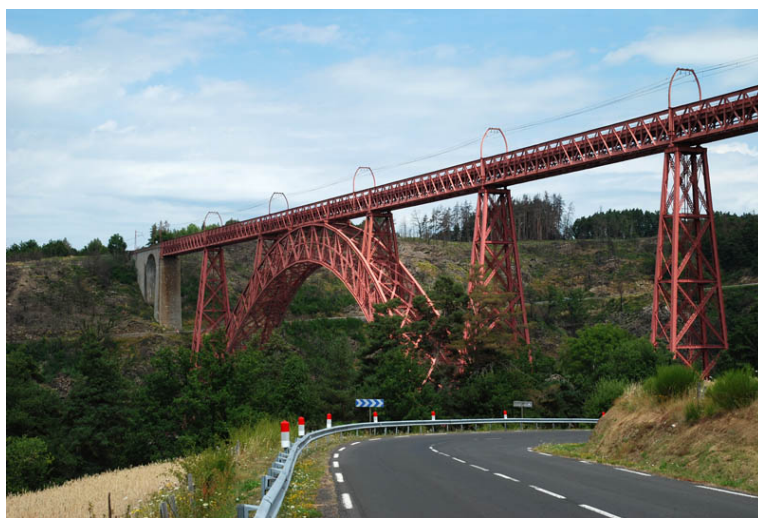
Viaducte de Garabit
