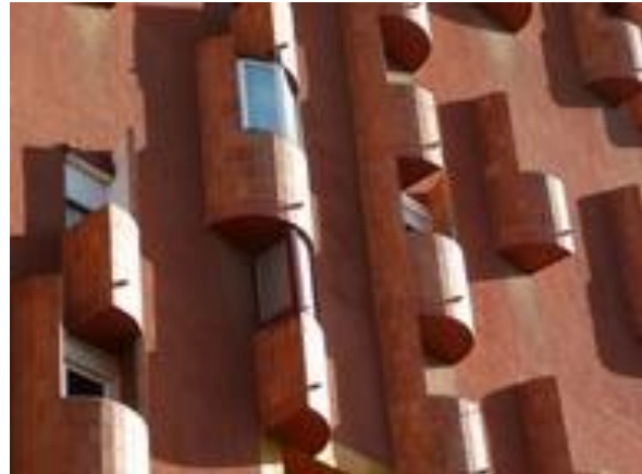
Ricard Bofill: Edifici Walden 7, 1974 (detall façana) (Sant Just Desvern)
