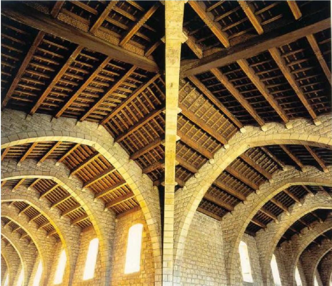
Arcs diafragma que sostenen un enteixinat
