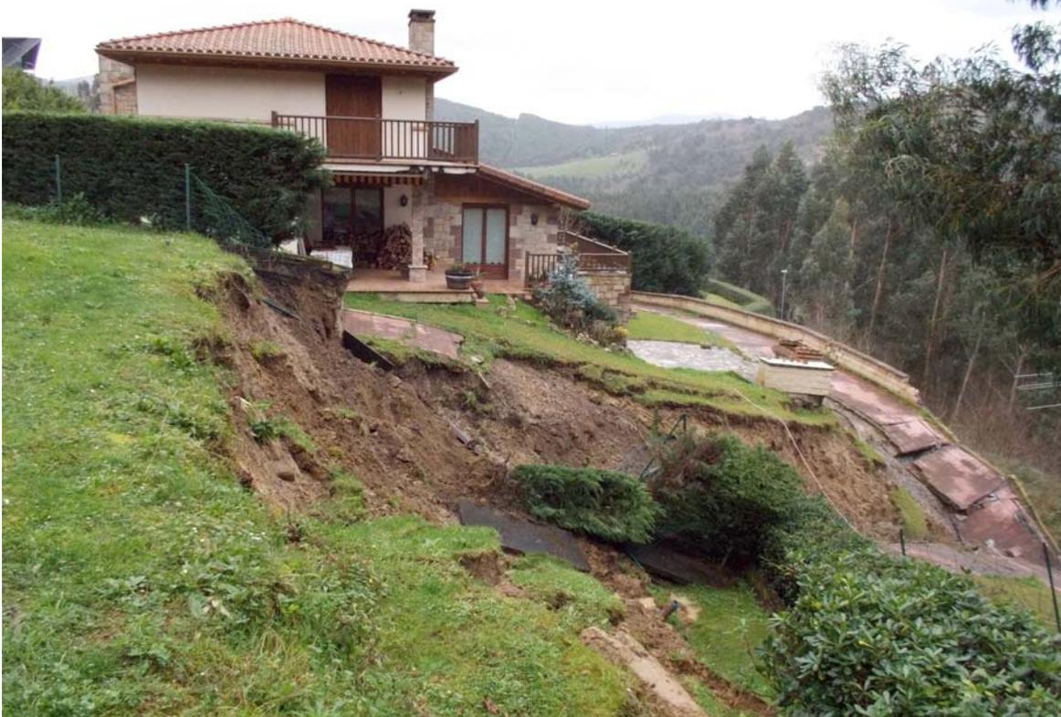
Imagen 8. Deslizamiento rotacional de suelos. En la imagen superior se observa el escarpe antes de que se produzca el movimiento final.
