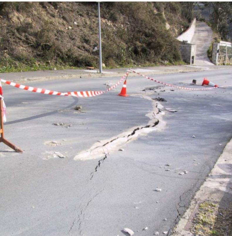
Imagen 29. Grietas en una carretera asfaltada. Se aprecia que las grietas han sido reparadas y se han abierto nuevamente.
