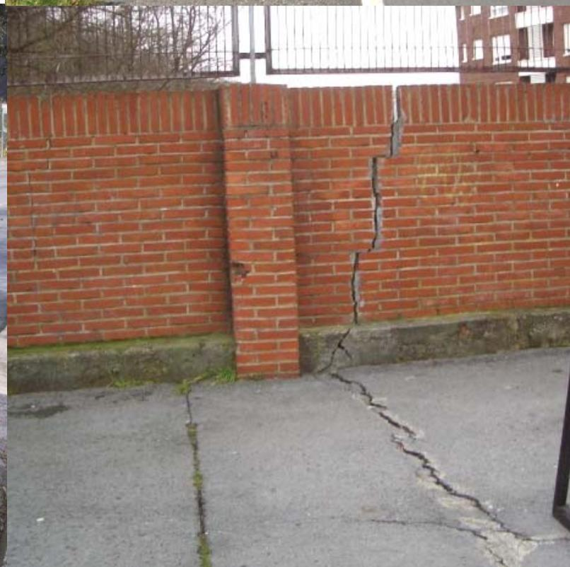
Imagen 30. Grietas en un pavimento y en un muro de ladrillos.
