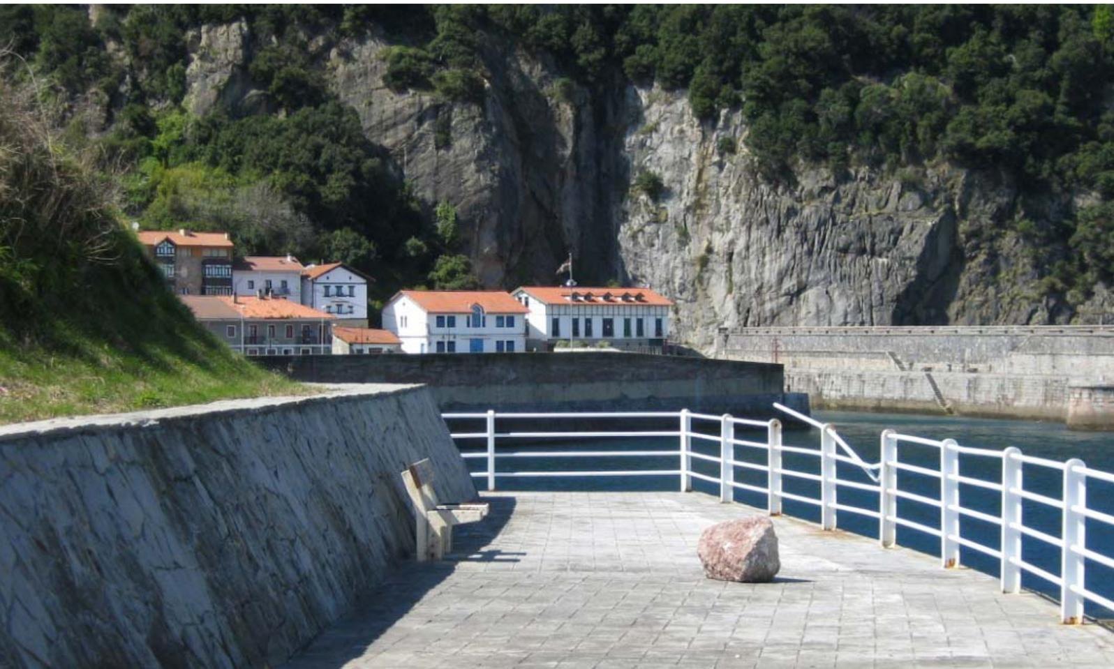
Imagen 10. Desprendimiento de bloque rocoso que ha rebotado y dañado la barandilla en una zona de tránsito sin riesgo aparente para transeúntes.
