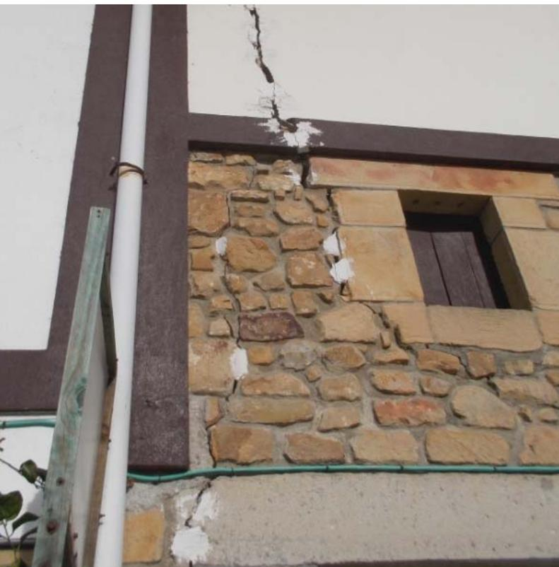
Imagen 26. Grietas reparadas en la fachada de una vivienda que han vuelto a abrirse.
