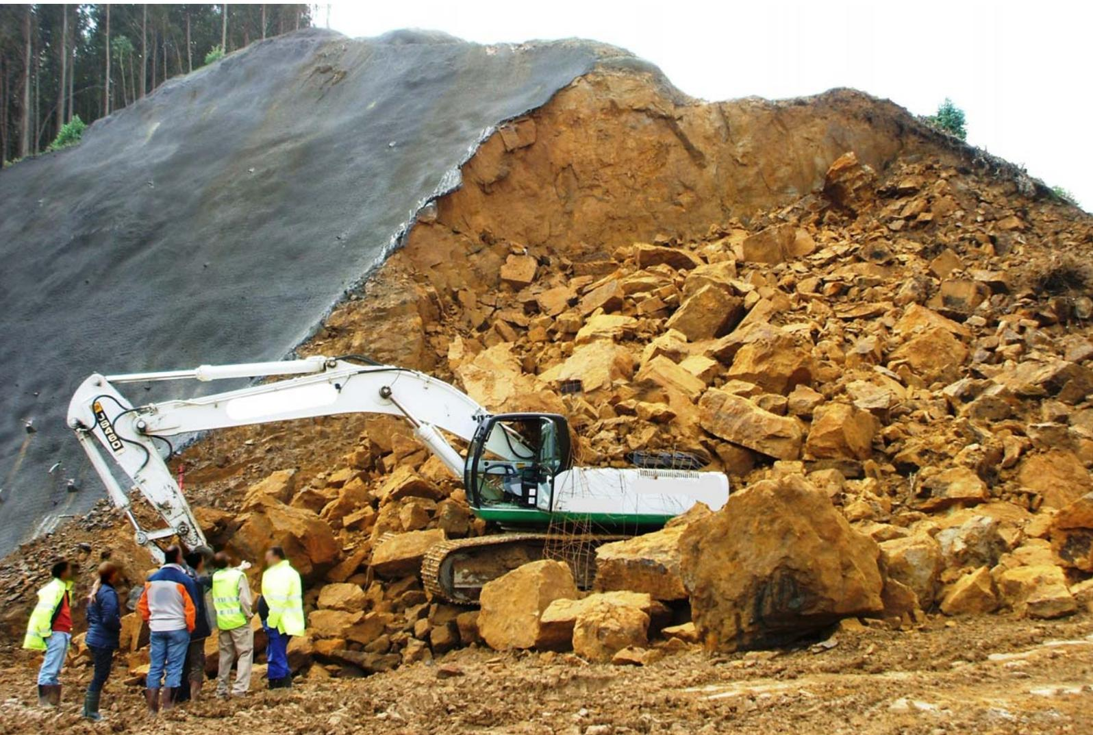
Imagen 16. Avalancha de rocas originada al excavar el pie de un talud.
