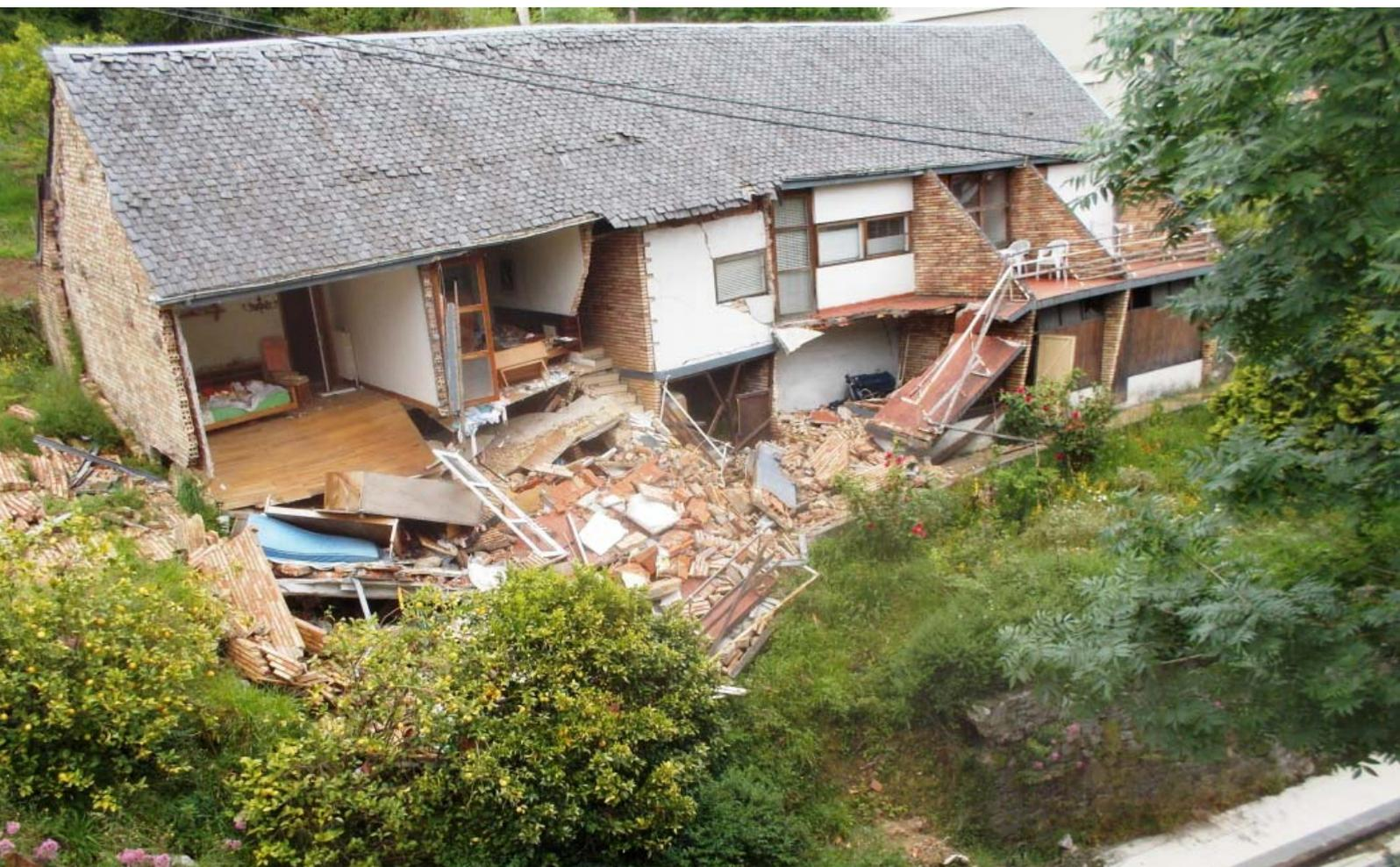
Imagen 1. Daños producidos en una vivienda afectada por un deslizamiento.
