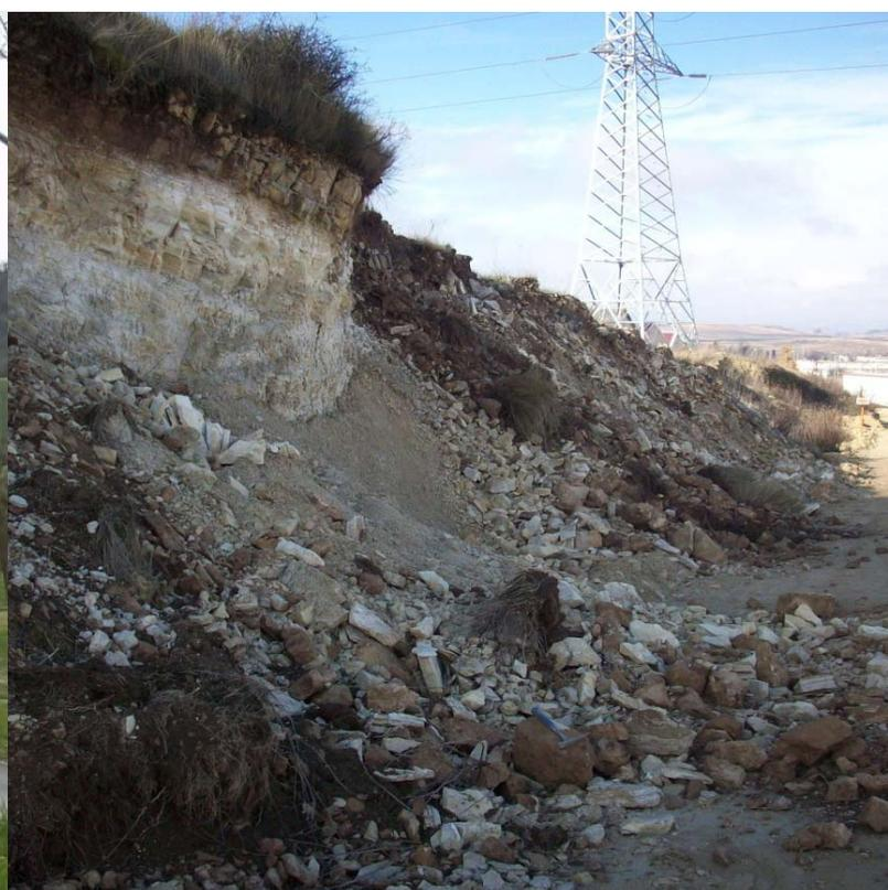
Imagen 22. Acumulación de bloques de roca y tierra en la base de un talud.
