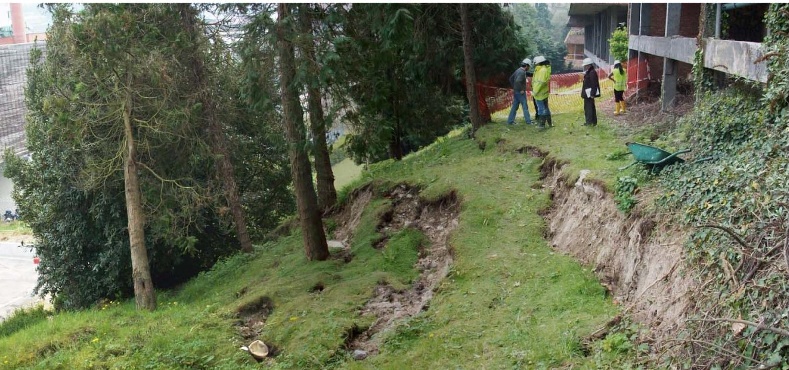
Imagen 2. Deslizamiento afectando a rellenos en una ladera cercana a la cimentación de un bloque de viviendas.
