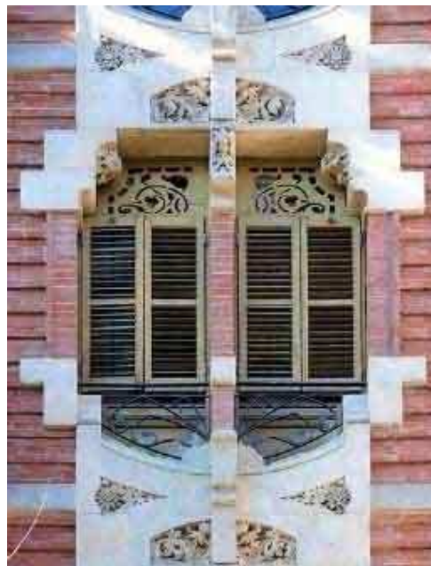
Detall de la façana de la Casa Domènech
