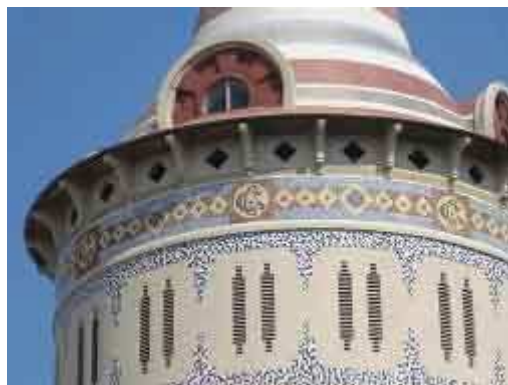
Torre de les aigües de la Fàbrica del Gas
