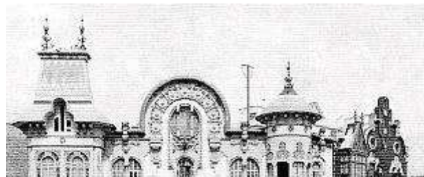
Coronaments desapareguts de la Casa Beloso
