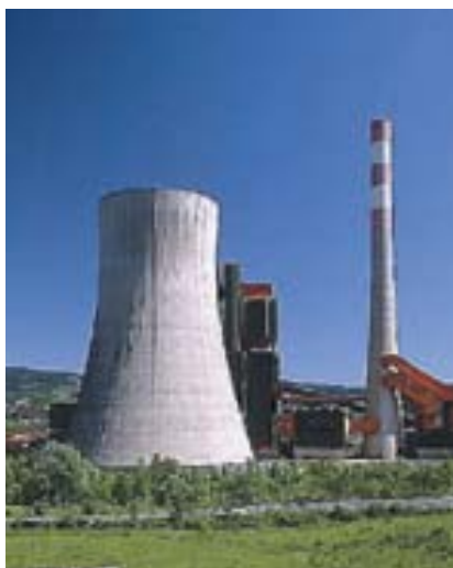
Torre de refrigeració i xemeneia d'una central tèrmica.
