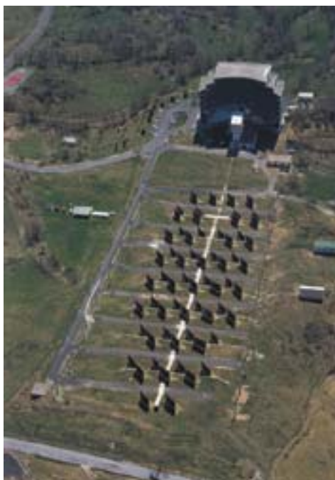
Forn solar instal·lat a Font Romeu (Alta Cerdanya). Una sèrie de miralls plans reflecteixen els raigs del sol sobre un mirall parabòlic gegantí que els concentra en el focus, on es troba el gresol del forn i on s'assoleixen temperatures de 3800 °C.
