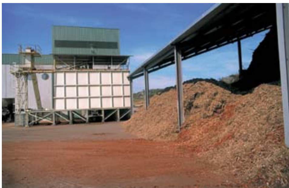
Planta de tractament de biomassa
