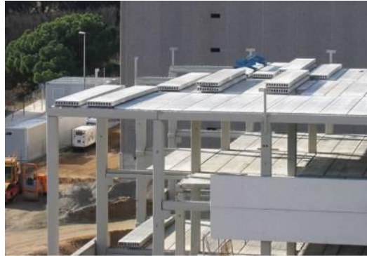
Pilars i bigues en una estructura de formigó
