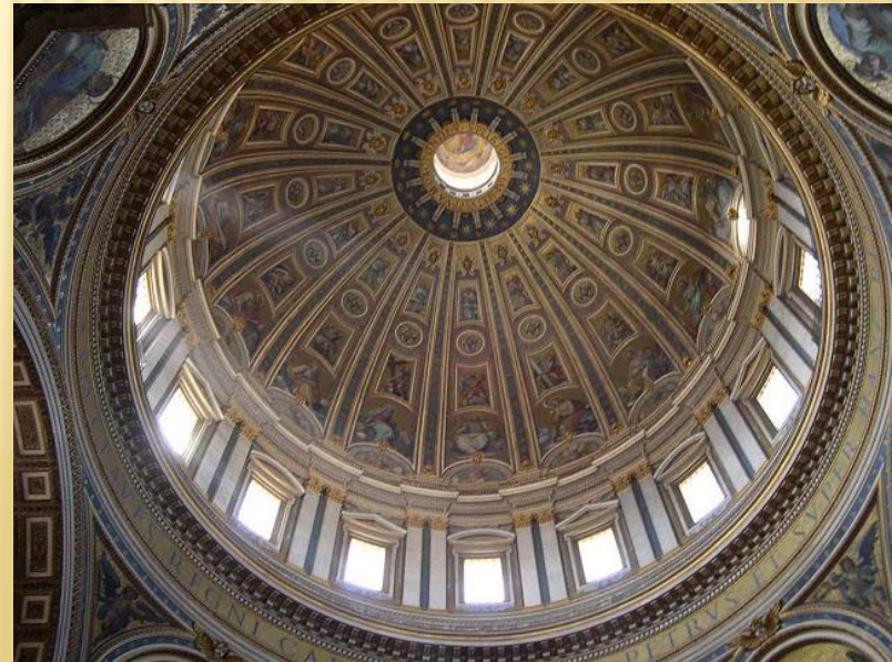
Interior de la cúpula
