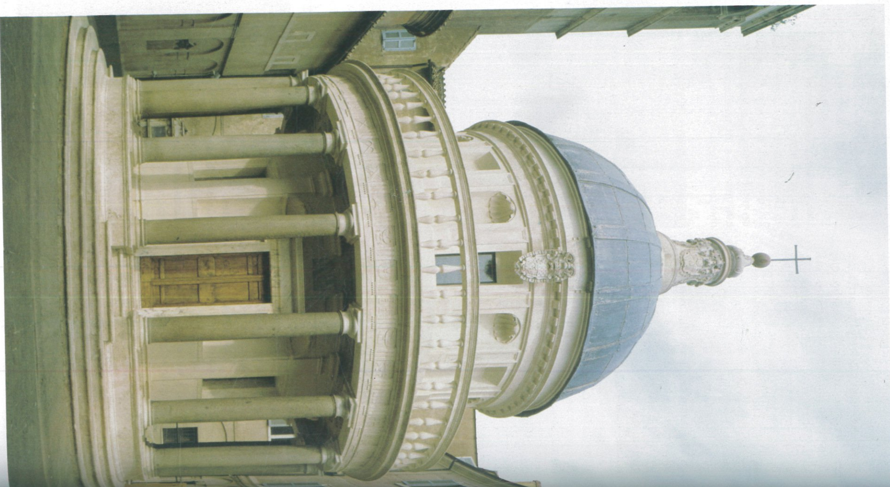
Detall de l'entaulament sobre capitells toscans.
