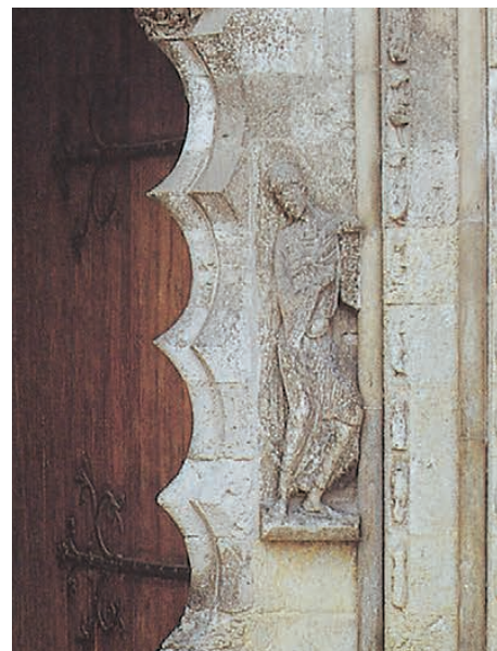
Detall d'un brancal lateral de l'entrada.
