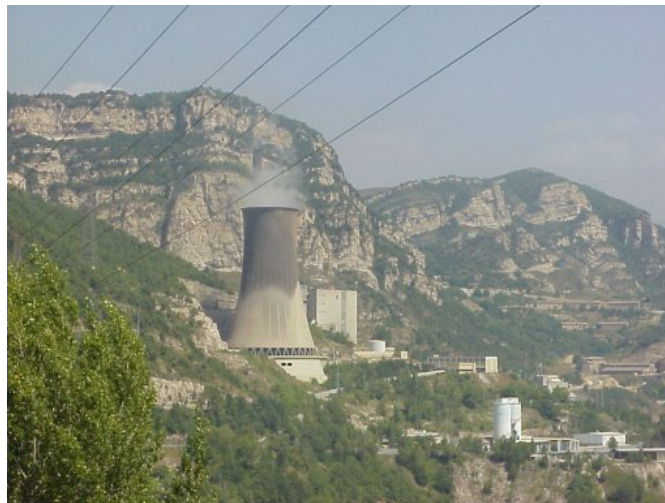
Central tèrmica de Cercs, Berguedà. Tancada des del 2012
